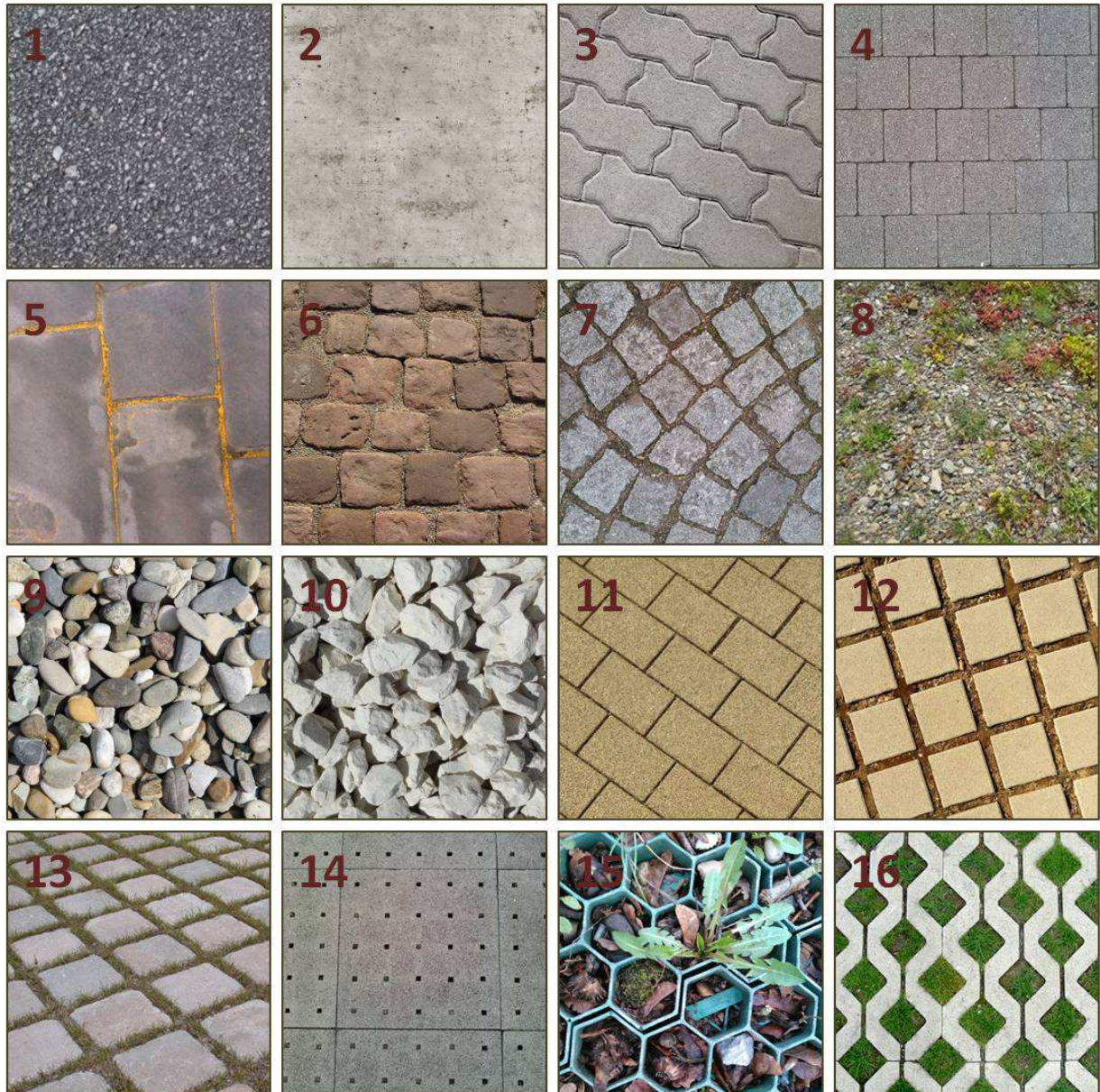
Abbildung 3-3: Bei der Feldaufnahme unterschiedene Bodenbeläge: Asphalt (1), Beton (2), Verbundpflaster (3, 4), Natursteinplatten (5), Natursteinpflaster mit Fugen (6, 7), Wassergebundene Decke aus Schotterrasen (8), Kies (9) oder Grus (10), Poren- oder Drainpflaster (11), Fugenpflaster ohne (12) und mit (13) Bewuchs, Baumscheiben-Lochplatten (14), Rasengittersteine aus PVC (11) oder Beton (12)
